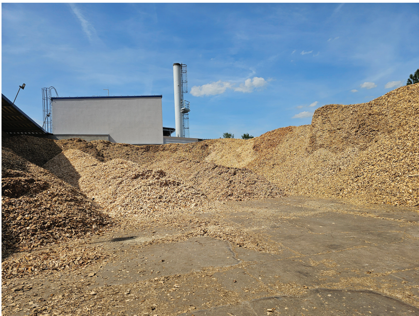
Flislager og varmesentralen som ble konvertert fra kull til flis i regi av Norsk Energi sitt prosjekt.
