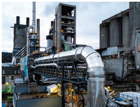
Brevik CCS blir i løpet av året verdens første sementfabrikk med CO 2 -fangst.
