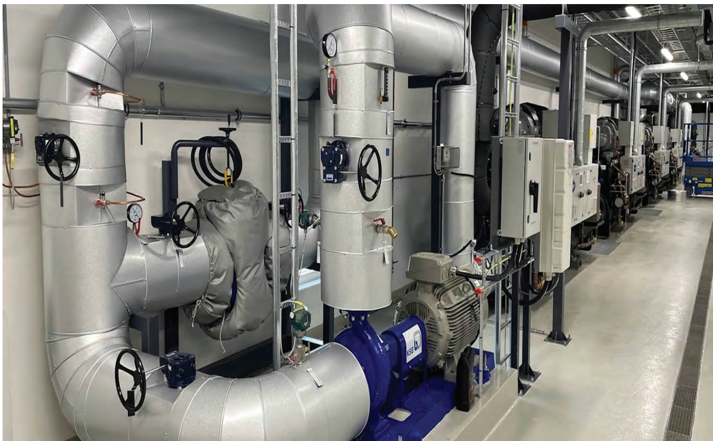
Fire varmepumper i serie sørger for å heve temperaturen på en vannstrøm i fjernvarmesystemet fra 50 til 80 oC.
