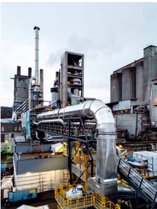
Brevik CCS blir i løpet av året verdens første sementfabrikk med CO 2 -fangst. (Foto: Heidelberg Materials)
