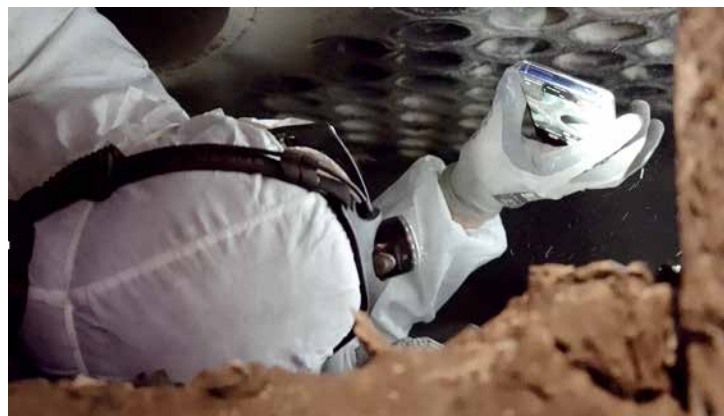
En grundig inspeksjon av kjelens røykgassside gjennomføres i forbindelse med en tilstandskontroll.
