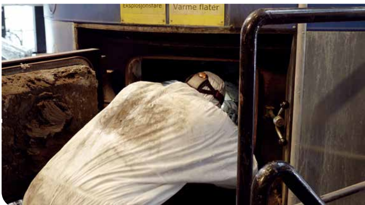
En grundig inspeksjon av kjelens røykgassside gjennomføres i forbindelse med en tilstandskontroll.
