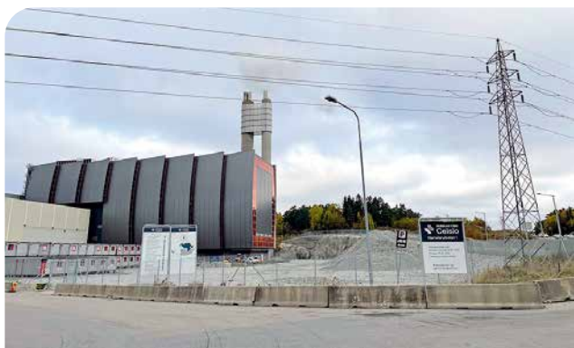
Norsk Energi er med på laget når Hafslund Celsio skal bygge et CO 2 -fangstanlegg på avfallsforbrenningsanlegget på Klemetsrud, Oslo. (Foto: Norsk Energi/Fredrik Even Hansen) Les mer om dette på side 16.
