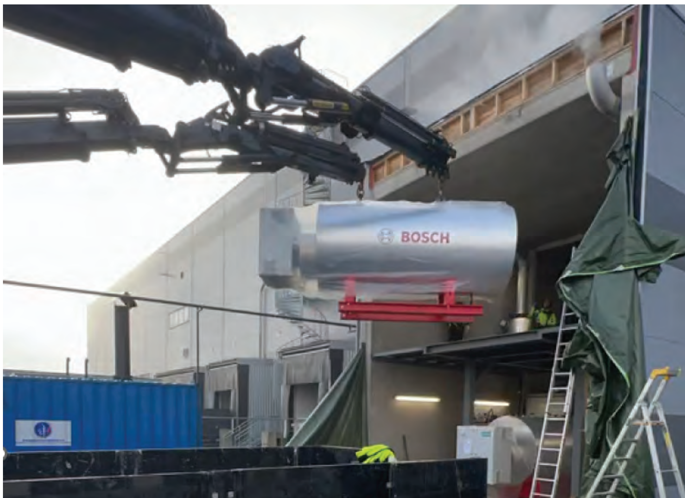
Innheising av elementkjel.
