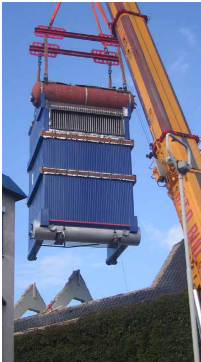
Den siste store industri-boomen som har betydd mye for Norsk Energi er fjernvarmeutbyggingen som særlig har skutt fart etter år 2000. Her løftes en av de 60 MW oljekjelene på plass i Hoff Varmesentral på Skøyen i Oslo den 1. september 2005.
