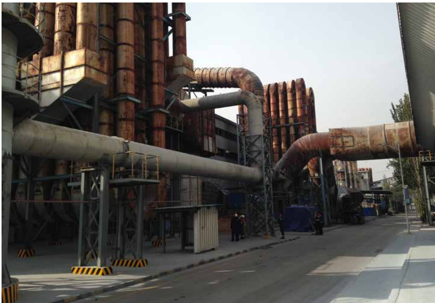
Beijing Bluestar Energy Conservation Investment Co sitt smelteverk i Yongdeng i Kina. Bildet viser dagens avgasskjølere (trombonekjølere), som brukes for å kjøle de varme ovngassene før de ledes inn på avgassfilteret. Dersom bedriften investerer i et energigjennvinningsanlegg vil dagens avgasskjølere likevel bli beholdt for å kunne kjøre avgassen i bypass når dette er nødvendig. I tillegg til kjeler og turbin med kondensator, vil det installeres kjøletårn og matevannstank. Foto: Ronny Valjord.
