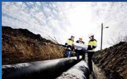
Fjernvarmeutbygging Stavanger og Sandnes – Lyse Neo
