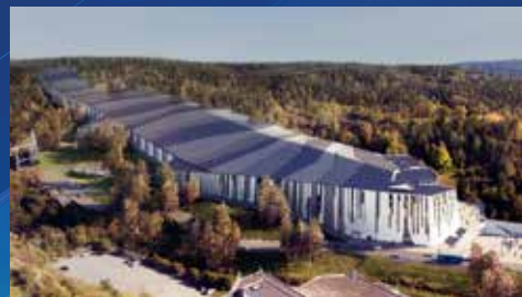
Energisentral og rørentreprise for kjøling og varmegjenvinning
