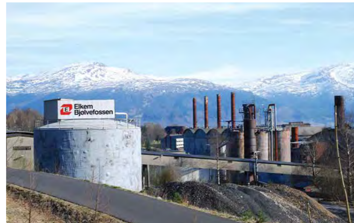
Elkem Bjølvefossen i Hardanger fikk et energigjenvinningsanlegg allerede i 1977. Foto: Thomas Andersen/Creatvie Commons
