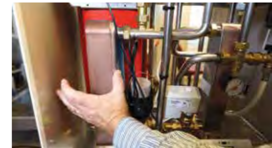
Det tredje røret er på plass. Foto: Anders Andersson/Halmstad University
