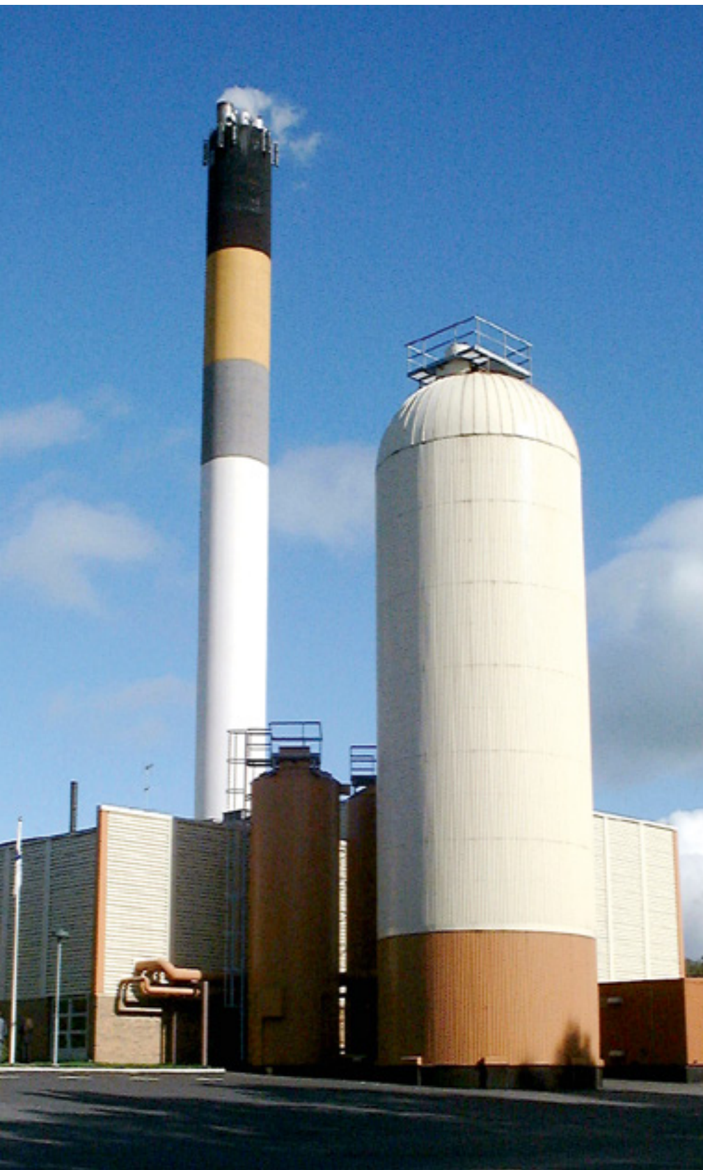
Figur 1. Akkumulatortank på ca. 500 m 3 ved Beleverket i Hässleholm, Sverige.
