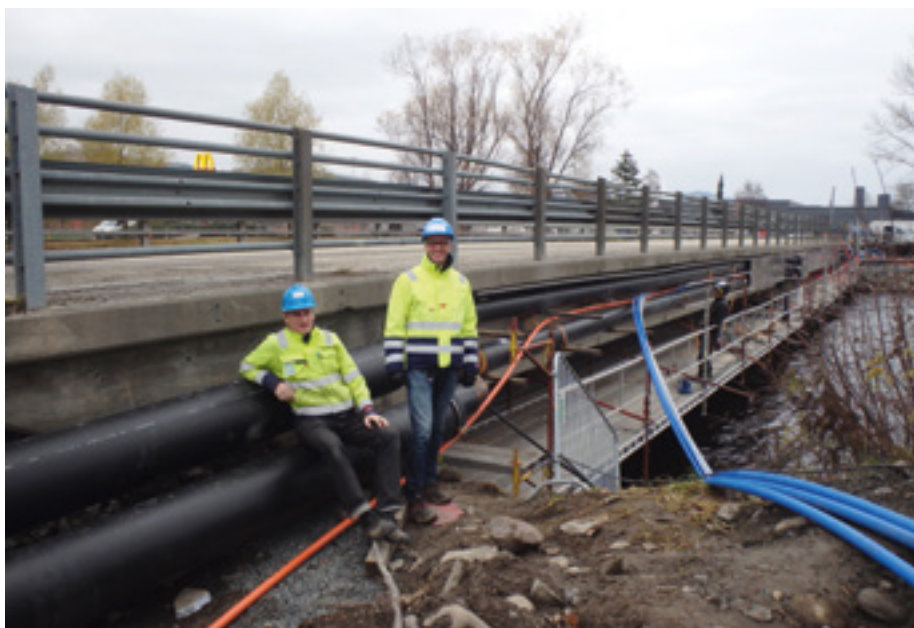
Brukryssing Huntonstranda. Eidsiva Bioenergis byggeleder Bjørn Romskaug (tv) og prosjektleder Svein Egil Linnerud.
