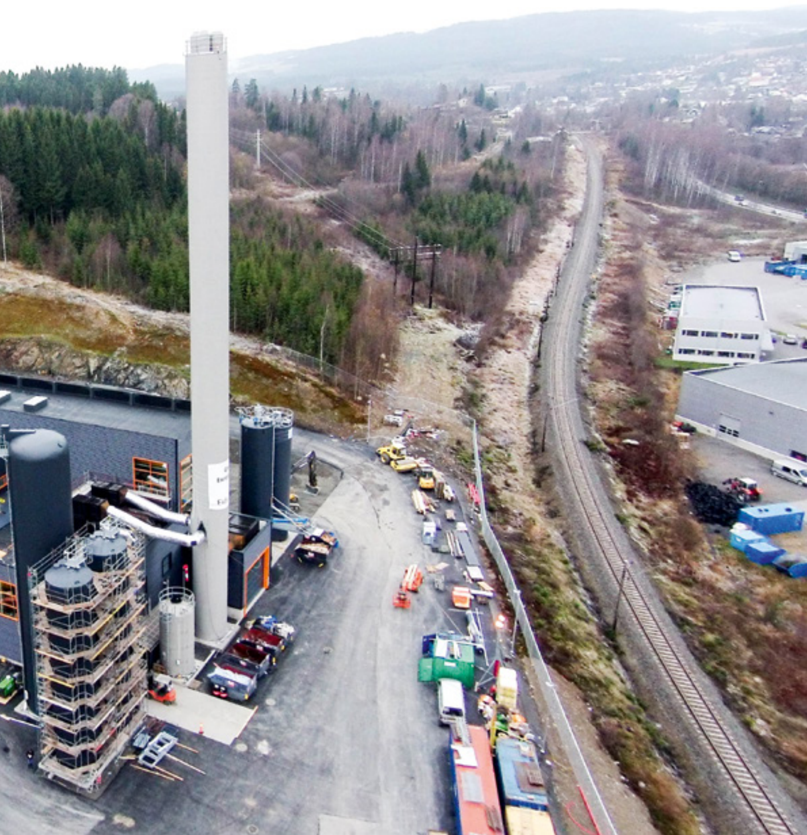
Gjøvik Energisentral ble satt i ordinær drift den 11. november i år. Eidsiva Bioenergi har her investert 280 millioner kroner, og forventer å kunne levere 60 GWh fjernvarme i året til Gjøvik. Fliskjelen har en effekt på 12 MW, og skal fyres med både returflis og skogsflis.
