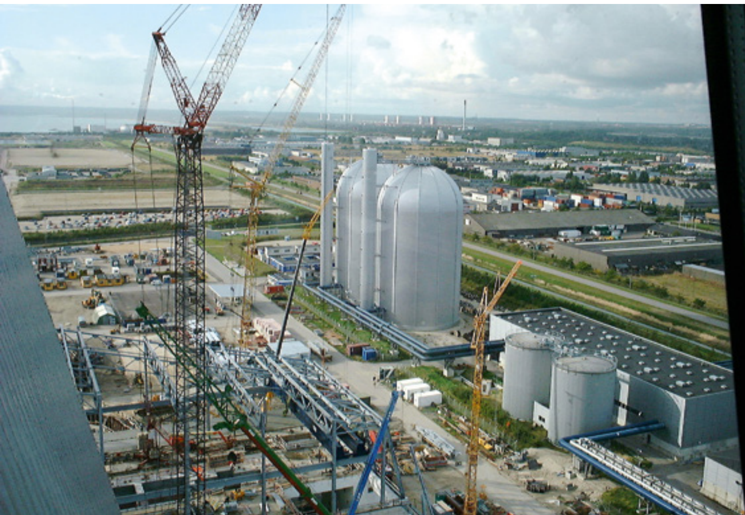
Figur 2. Akkumulatortanker ved Avedøreverket utenfor København (2x22.000 m 3 )
