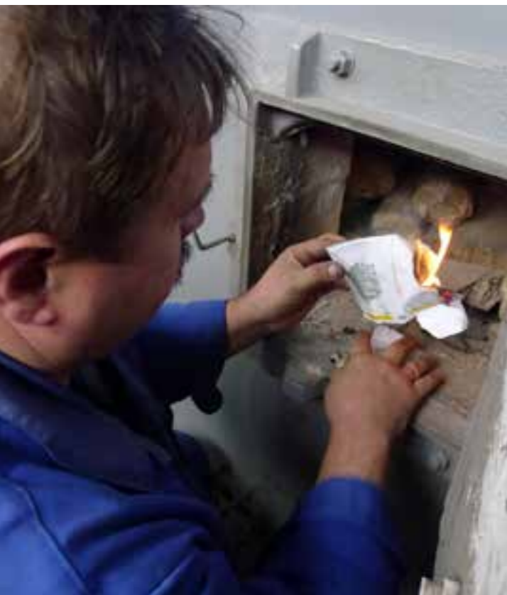
Det er installert mange nye bioenergikjeler i Komi-republikken de siste årene med støtte fra industriministeriet. Her fra første gangs oppfyring av en ny brikettkjel.
