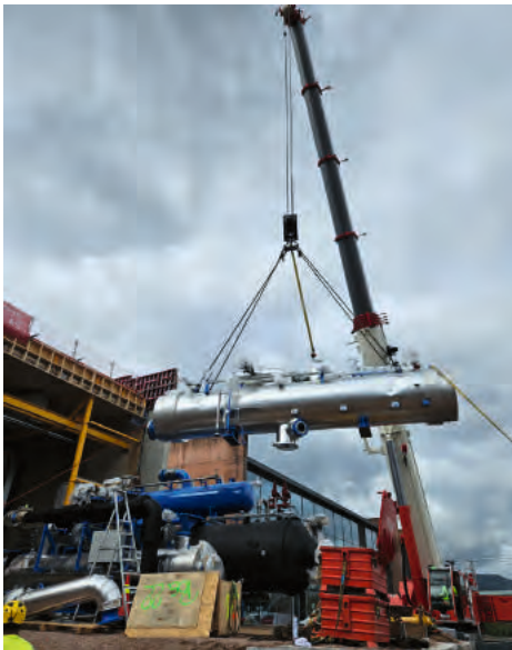
Løft av kondensatorenhet.
