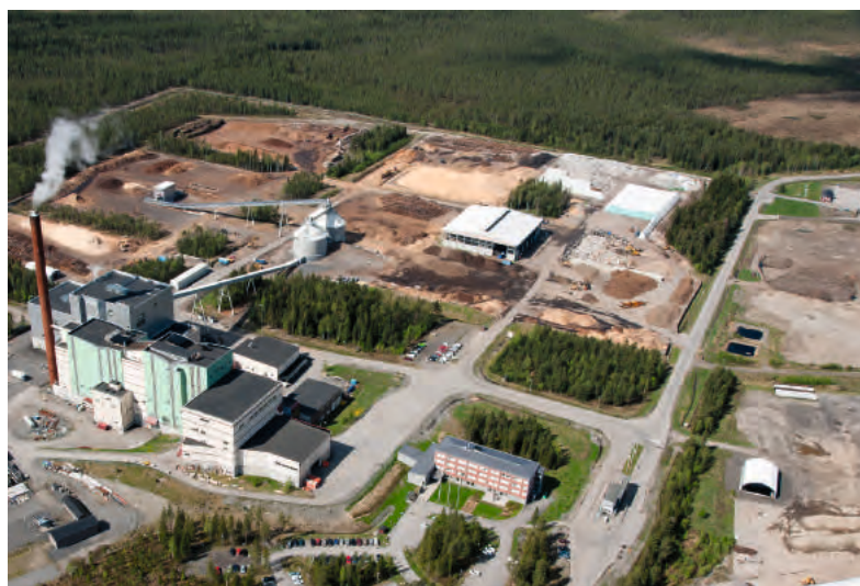
Dåva kraftvarmeverk i Umeå får Liquid Winds Flagship 3 som nabo. I Norden er målet å nå investeringsbesluttet produksjon for totalt 8 millioner tonn elektrobrensel før 2030, spredt på en rekke prosessanlegg.
