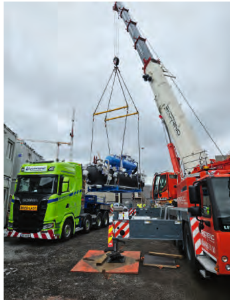
Løft av fordamperskid.
