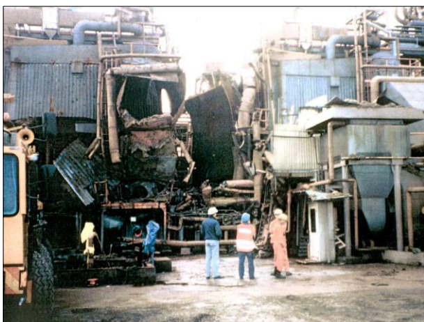
Eksempel på uønsket hendelse - gassesplosjon på kjel
